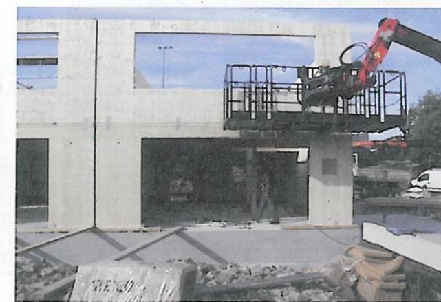
La pose du KLH. Les panneaux trois plis permettent des durées de chantier très courtes.
