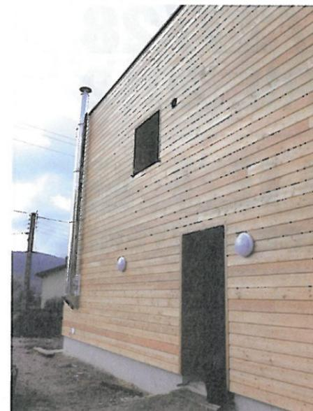
Sur le bardage bois extérieur, un des conduits d'évacuation des fumées pour un poêle passif individuel.
